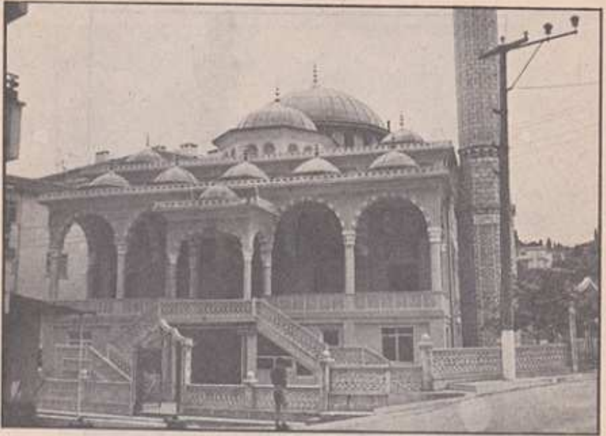
Çınarcık Taslman Camii giriş cephesi
